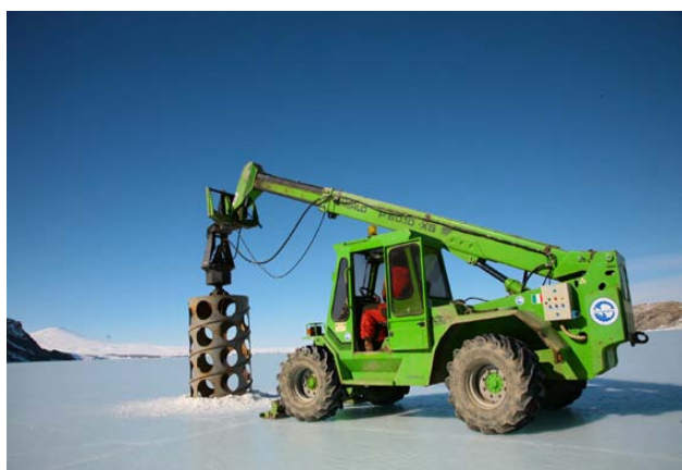
Fig. 3 - Foro in realizzazione
